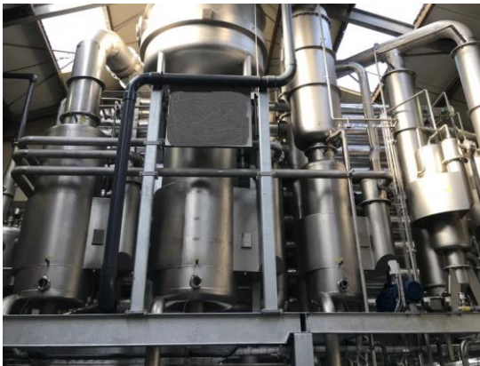
1. Ábra: VP-Hoberendszer \text{NH}_3 víz előállítására (ID:1527)
