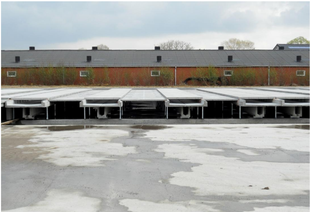
Figura 1. Impianto per il recupero di N come urina da letame suino mediante il sistema di adattamento della stalla "VeDoWS".
