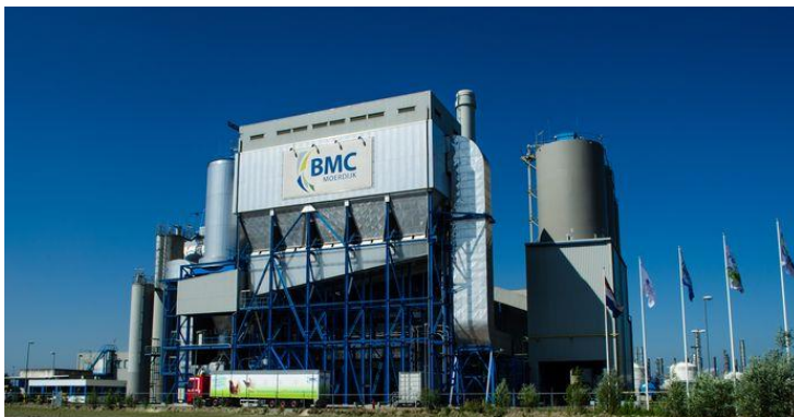
De BioMassaCentrale (BMC) Moerdijk. © BMC Moerdijk
