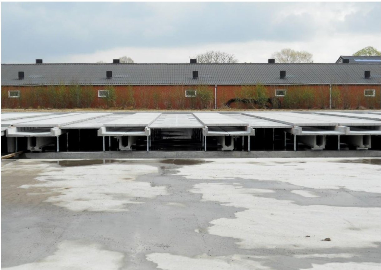
Figure 1. Installation pour la récupération de l'azote sous forme d'urine à partir de fumier de porc avec un système de construction d'étable adapté au "VeDoWS".
