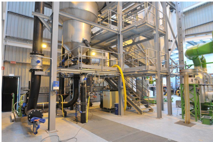
Figura 1. Tecnología de recuperación de P en estruvita del proceso de "Canal de Isabel II S.A.".
