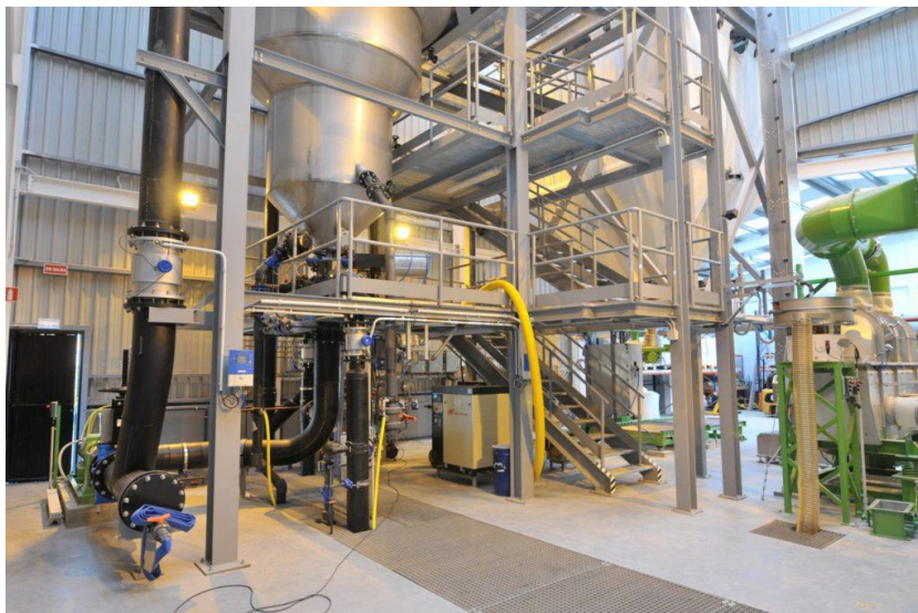
Figuur 1. Technologie voor P recuperatie als struvite door het "Canal de Isabel II S.A." proces
