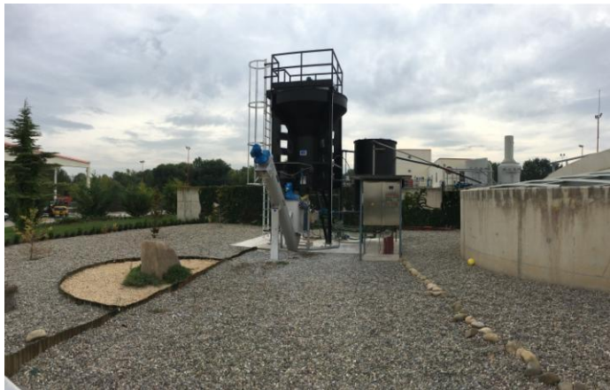
Reactor de cristalización PHORWater.
