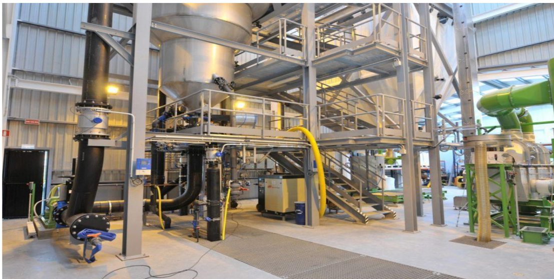
Rysunek 1. Instalacja dla procesu odzyskiwania P w postaci struwitu firmy „Canal de Isabel II SA”
